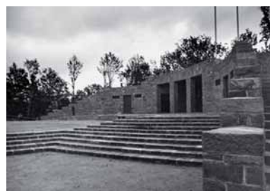
303 Bühnengebäude, Aufnahmen nach Fertigstellung
