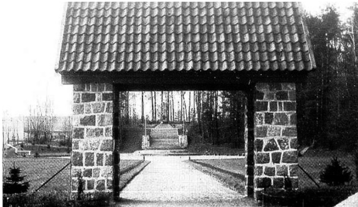
Nordenburg. Eingangstore zum Territorium des Komplexes. Im Hintergrund ist der Thingplatz zu sehen. Ende der 1930er/Anfang der 1940er Jahre.
